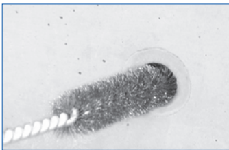
Mauerstärke reinigen
