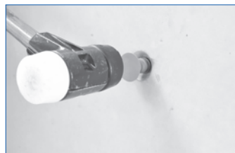
Dichtstopper mit Spezialhammer einschlagen
