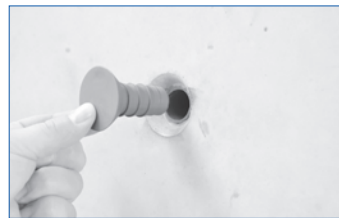
Dichtstopper einsetzen
